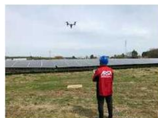
太陽光パネル 設備点検
