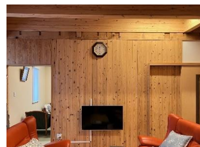
福島県内お寺の庫裏内部の調査
