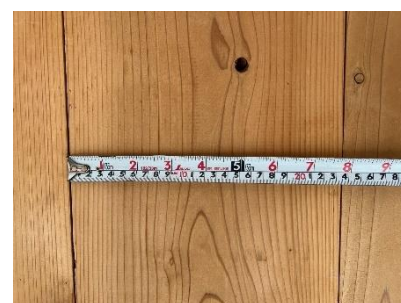
パネルの乾燥収縮寸法を確認
