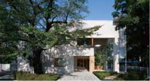
②郡山地域テクノポリスものづくりインキュベーションセンター (日本大学工学部キャンパス内)
