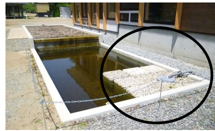
水質浄化用ポーラスコンクリートブロック
