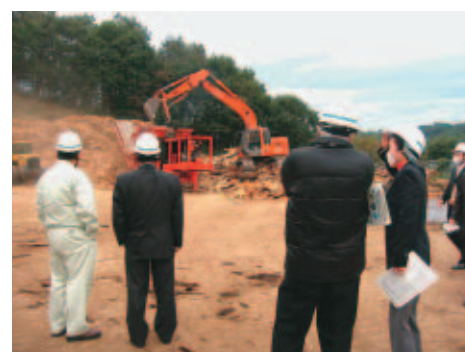
株式会社 白河ウッドパワー 大信発電所
