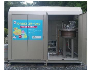
バイオマス実験装置1号機 (日大工学部内に設置)
